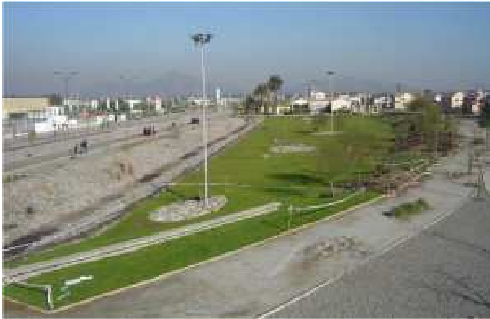
Figura 14 - Reservatório de detenção aliado a técnicas paisagísticas e lazer em Santiago, Chile. (Fonte: aquafluxus.com.br/paisagens-multifuncionais )
