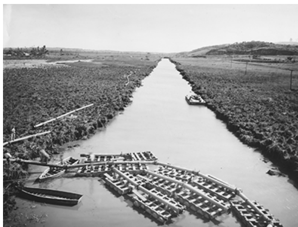
Figura 4 - A retificação: primeiro corte do Canal do Rio Pinheiros em direção sul da Avenida Cidade Jardim. No lado esquerdo, trabalhadores na margem do rio em 1936. (Fonte: energiaesaneamento.org.br/1912 )
